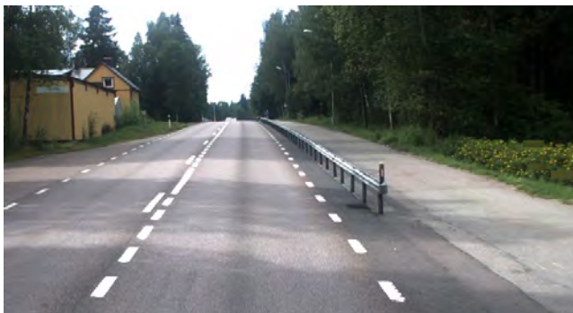
Bilklyvande räckesände intill körbana (70 km/tim) på Rv 50 vid Ludvika. Foto: Trafikverket PMSv4.
