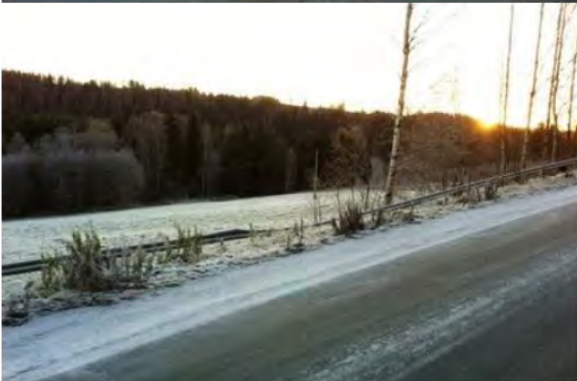
Vägräcken i Sollefteå där räcket är i nivå med, respektive under, vägbanan. Foto: J Granlund.
